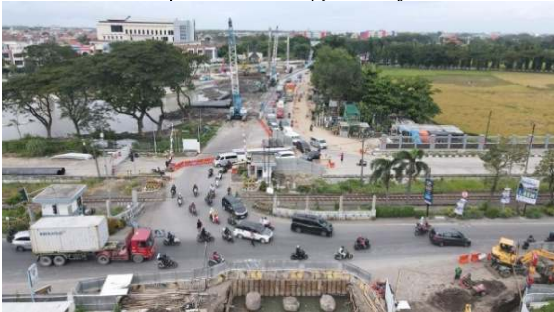
Gambar 2. Flyover Aloha Ketika Konstruksi Sumber: Nindya KSO, 2023
